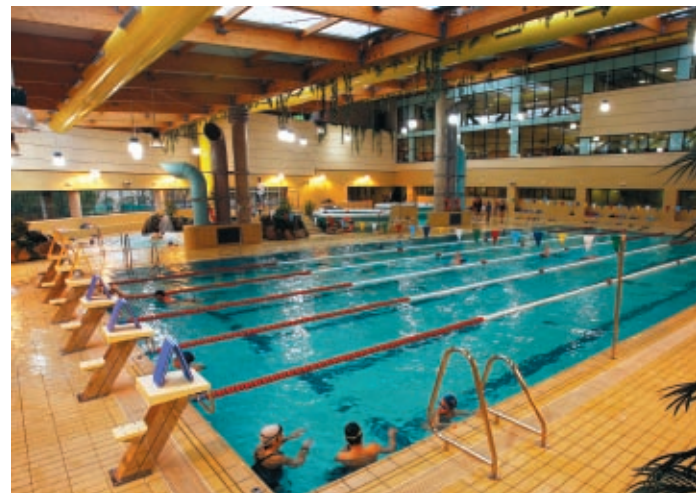
El estudio pone de relieve los grandes rendimientos que pueden obtenerse en instalaciones deportivas y, en especial, en piscinas cubiertas.
