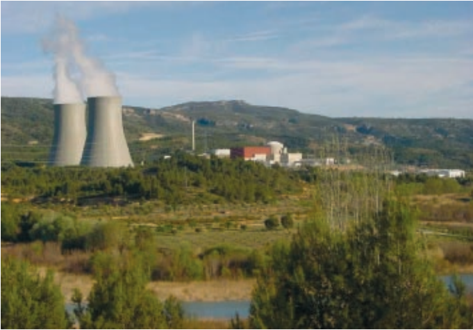
Central Nuclear de Zorita, en proceso de desmantelamiento.
